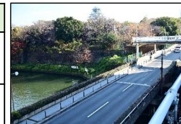
架替代表橋梁 京橋
