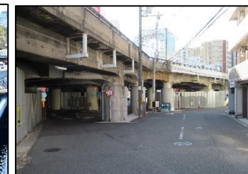
大規模長寿命化代表橋梁 中津高架橋
