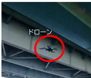
写真 1-1 飛行型ドローンによる点検状況
