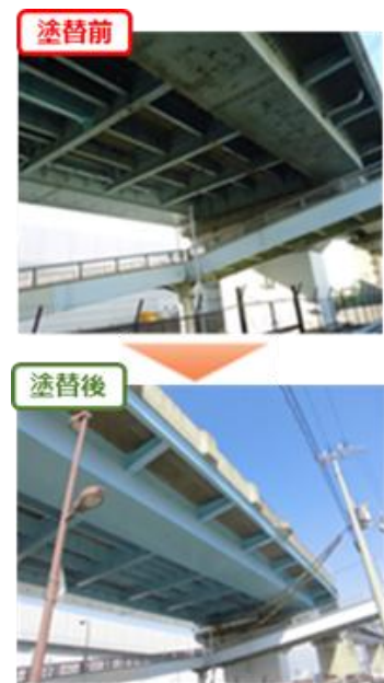
図 2-3 塗装塗替前後の例
