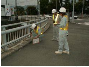
(参考) 橋面の点検状況イメージ
