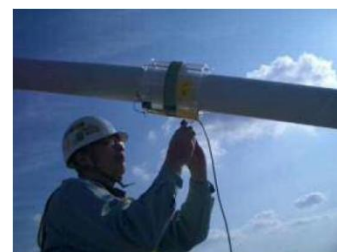
ケーブルの非破壊調査
