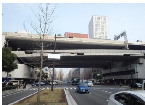
船場高架橋（御堂筋跨道橋）
