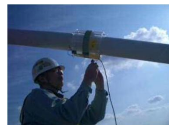
ケーブルの非破壊調査
