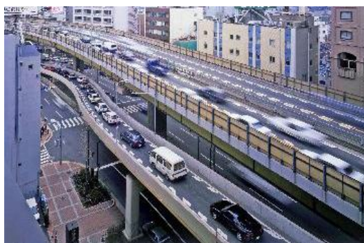
新御堂筋線高架橋
