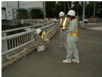
(参考) 橋面の点検状況イメージ
