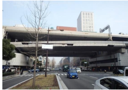
船場高架橋（御堂筋跨道橋）
