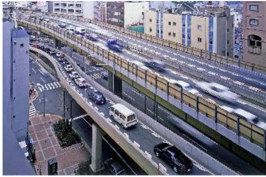
新御堂筋線高架橋
