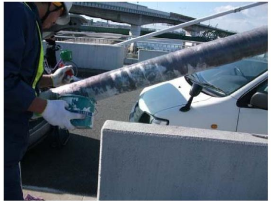
樹脂塗布含浸（FRP下塗り工程完了）
