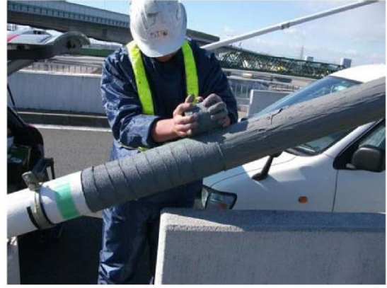
防食テープ巻き付け
