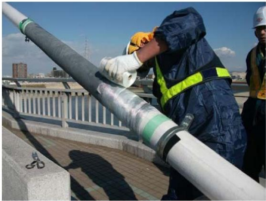
ガラスクロステープ巻き付け
