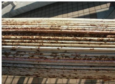
上面 素線間に溝あり ケレン前
