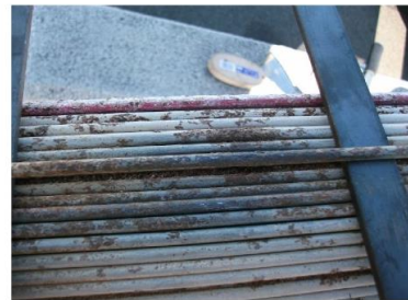
錆が目立つ箇所
