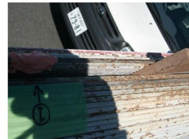
内層素線確認（上面クビ割り）
