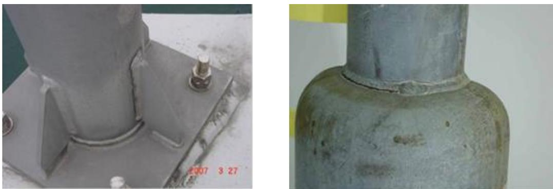
写真-2.1 支柱基部や支柱断面変化部のき裂変状事例
