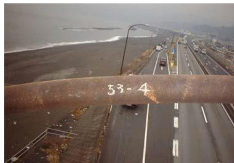
写真-2.4 支柱本体の腐食事例
