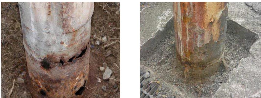
写真-2.2 路面境界部の腐食事例
