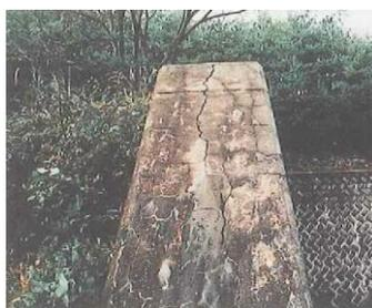
鉄筋方向に沿ったひび割れ
