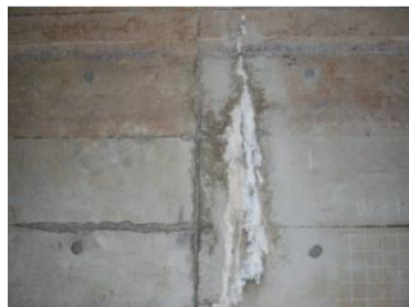
損傷区分「d」 (遊離石灰)
