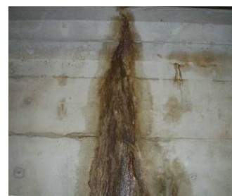
損傷区分「e」 (錆汁)
