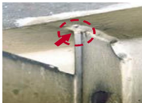
損傷区分「c」 (接合部、塗膜割れ)
