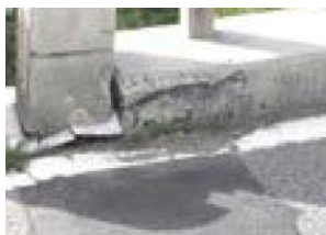
損傷区分「e」 (著しい欠損)
