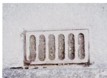
損傷区分「e」 (土砂詰り)
