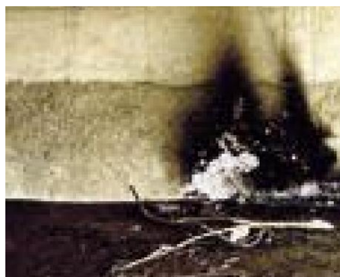
損傷区分「e」 (火災による変色)
