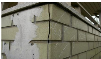
損傷区分「e」 (タイルの浮きを伴った剥離)
