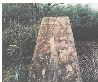
鉄筋方向に沿ったひび割れ
