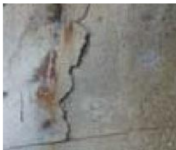
損傷区分「d」 (浮き)
