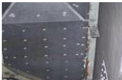
損傷区分「c」 (シール部一部剥離・錆)
