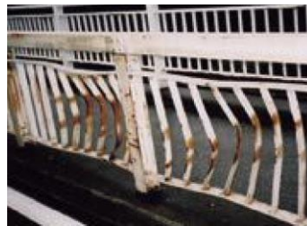
損傷区分「e」 (著しい変形)
