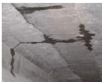
損傷区分「c」 (漏水)
