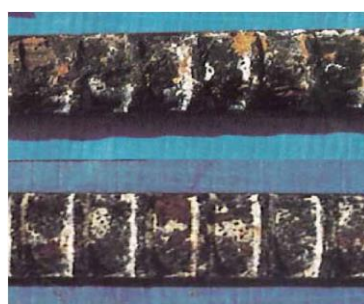
損傷区分「e」 (著しい腐食、全体的なさび)
