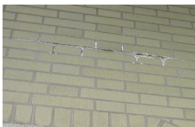
損傷区分「d」 (遊離石灰)
