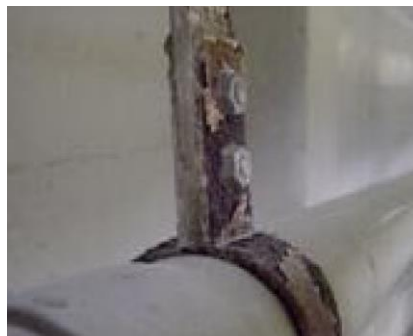
損傷区分「e」 (板厚減少、広範囲腐食)
