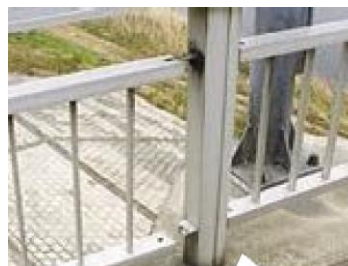
損傷区分「e」 (継手部が破断)
