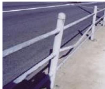
損傷区分「c」 (変形)
