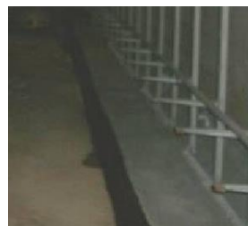
損傷区分「c」 (排水溝の滞水)
