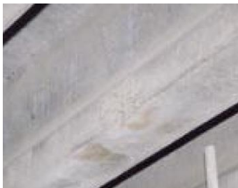
損傷区分「c」 (剥離)
