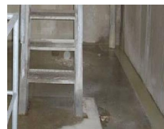
損傷区分「e」 (排水溝から漏出)
