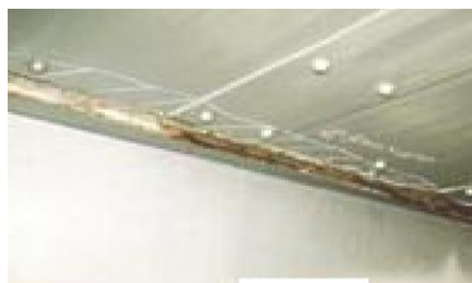
損傷区分「e」 (浮き・錆および著しい漏水)
