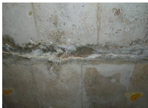
損傷区分「c」 (目地部から漏水)
