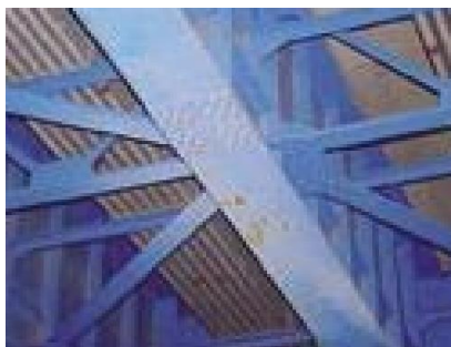
損傷区分「b」 (表面のみ、局部的腐食)
