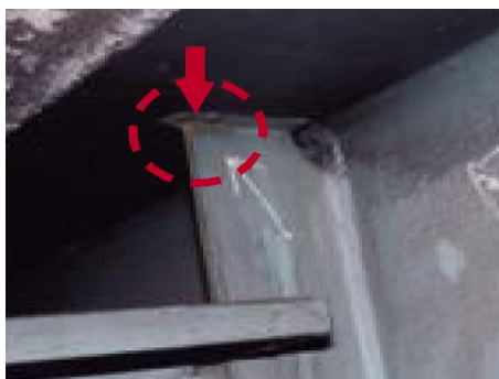
損傷区分「c」 (接合部、短い亀裂)
