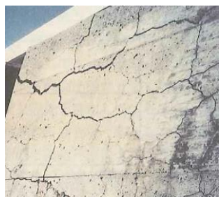
亀甲状のひび割れ
