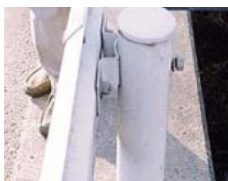
損傷区分「c」 (ゆるみ1本のみ)
