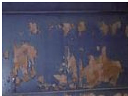
損傷区分「c」 (表面のみ、広範囲腐食)
