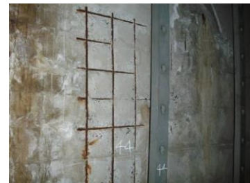
損傷区分「e」 (鉄筋露出、著しい腐食)
