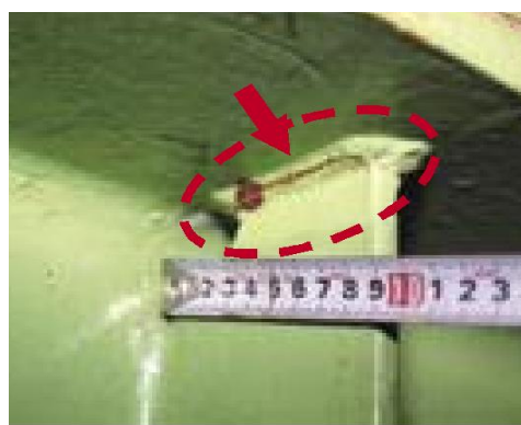
損傷区分「e」 (塗膜割れ、錆)
