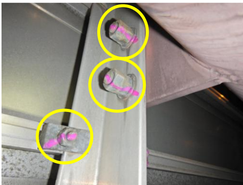
写真4.5-1 合いマーク及び標識板の落下防止対策（ワイヤー設置）の例
