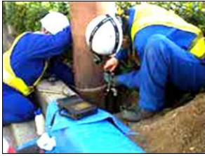
施設の点検状況イメージ
