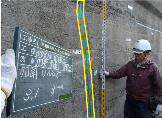
写真 4.5-2 修繕例（ひび割れ注入工）
