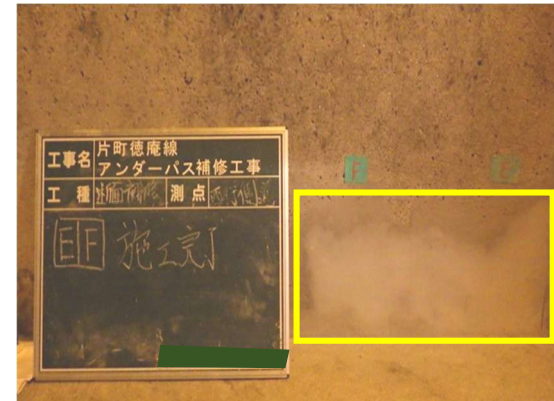
写真 4.5-3 修繕例（断面修復工）
