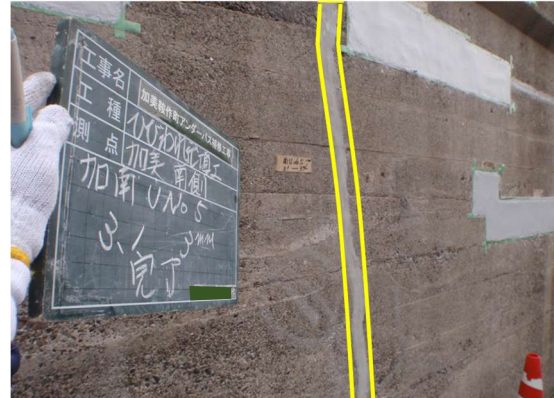
写真 4.5-2 修繕例（ひび割れ注入工）
