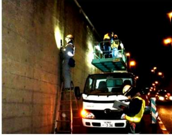
施設の点検状況イメージ
