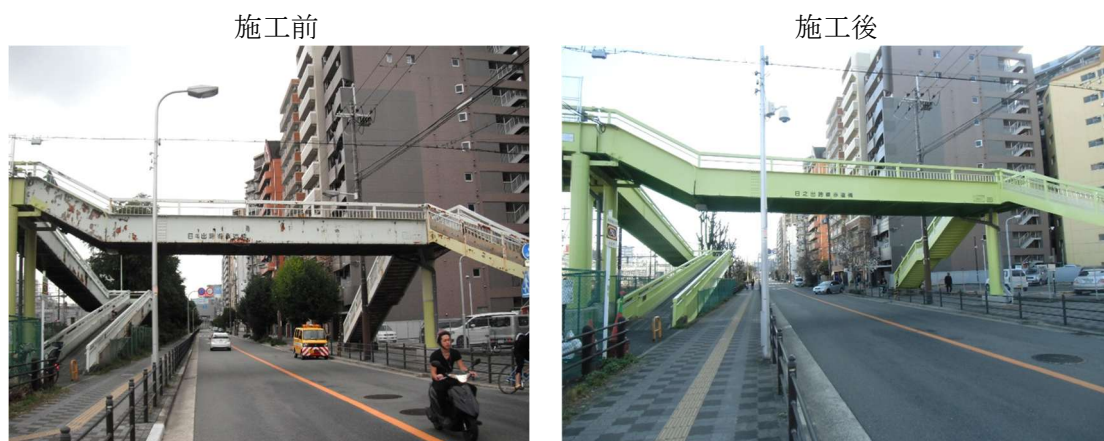
写真 4.5-3 修繕例（塗装塗替）
