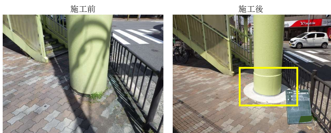
写真 4. 5 - 2 修繕例（耐震対策）
