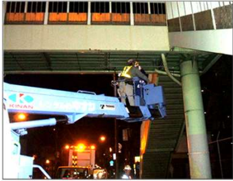
施設の点検状況イメージ
