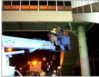
施設の点検状況イメージ
