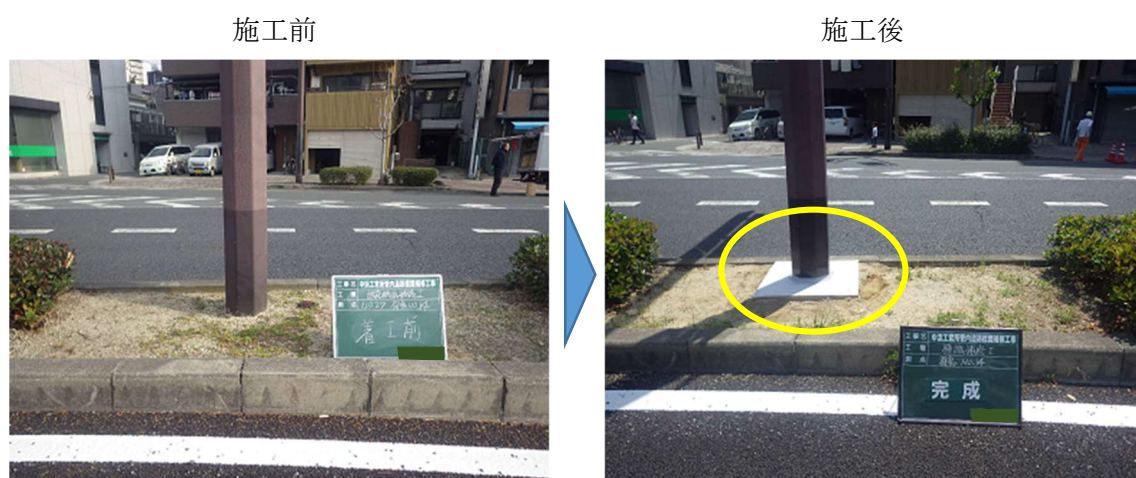
写真 4.5-2 延命化対策の例（根巻きコンクリートの設置）
