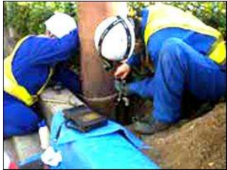
施設の点検状況イメージ
