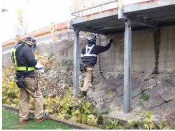
施設の点検状況イメージ
