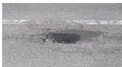
損傷区分「c」 h < 20\text{mm} 、ポットホール W \geq 15\text{cm}
