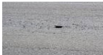
損傷区分「d」 h \geq 20\text{mm} 、ポットホール W < 15\text{cm}
