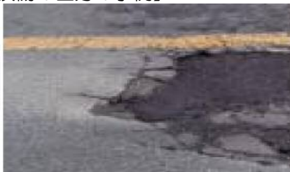
損傷区分「c」 h < 20\text{mm} 、ポットホール W \geq 15\text{cm}
