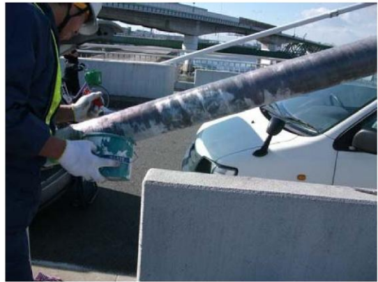
樹脂塗布含浸（FRP下塗り工程完了）
