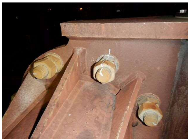
横梁取付部（東側）
