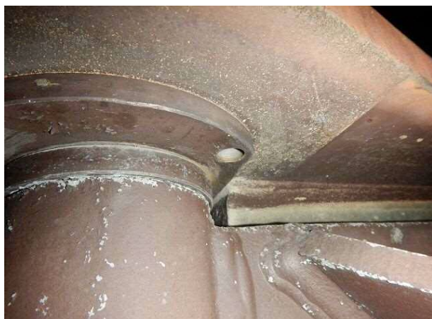
横梁取付部（東側）
