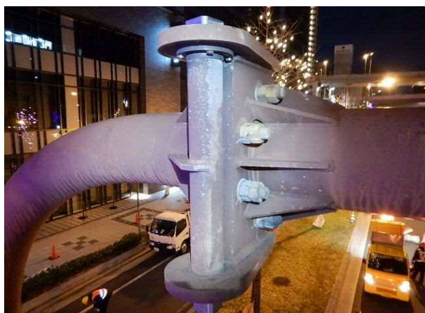
横梁取付部（西側）
