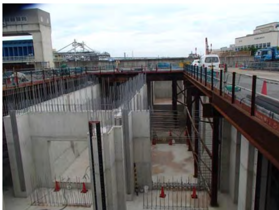
沈砂池となる水槽を 建設している様子(躯体工)
