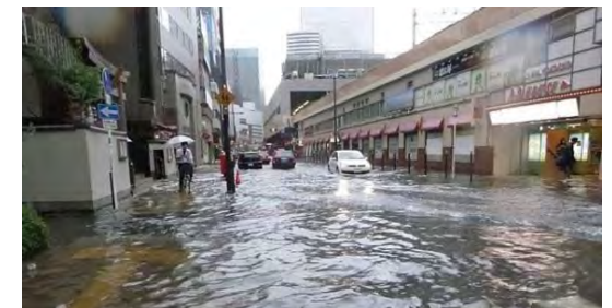
平成25年8月25日の浸水状況 (大阪市北区)
