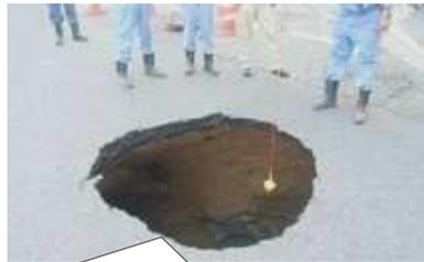
陥没の原因となった老朽化した下水管の状況 (崩落した管渠の破片)
