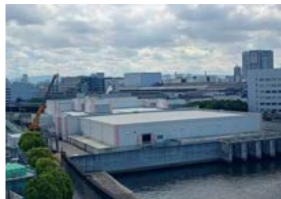
ポンプ棟全景
