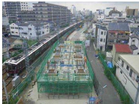
現在線横に高架橋を構築
