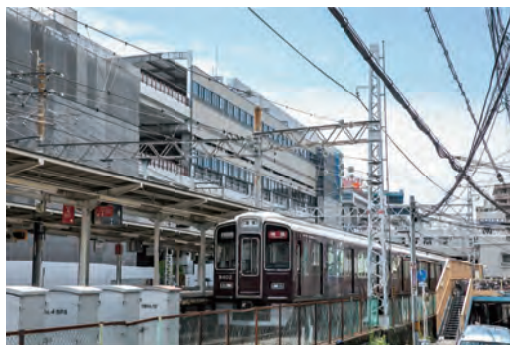
現在線横に高架橋を構築
