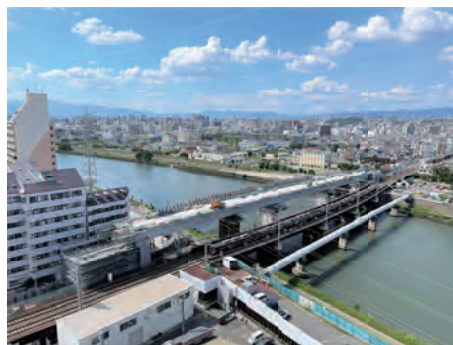
現在線を仮線に切替え、現在線跡地に高架橋を構築
