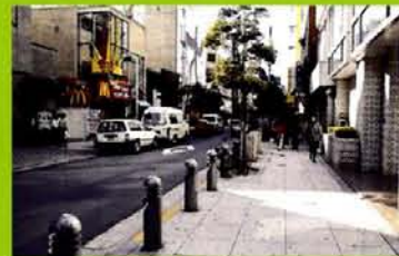
周防町通【電線類の地中化】
