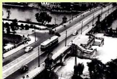
難波橋(堺筋)【道路の拡幅整備】
