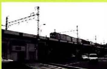
国鉄西成線(現JR大阪環状線) 【鉄道の立体的整備】
