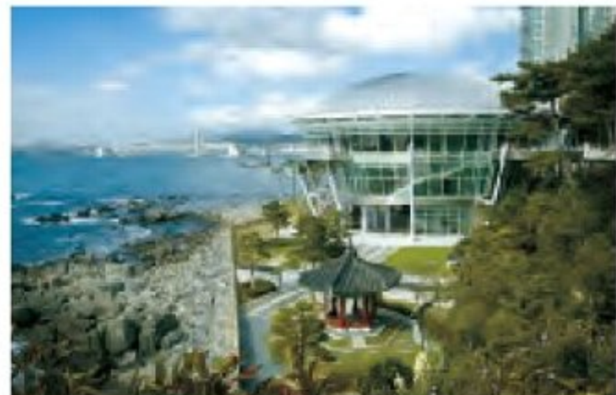
■ Nurimaru APEC House
