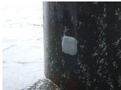
写真8 仮補修材
