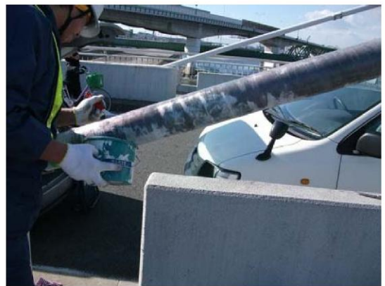
樹脂塗布含浸（FRP下塗り工程完了）
