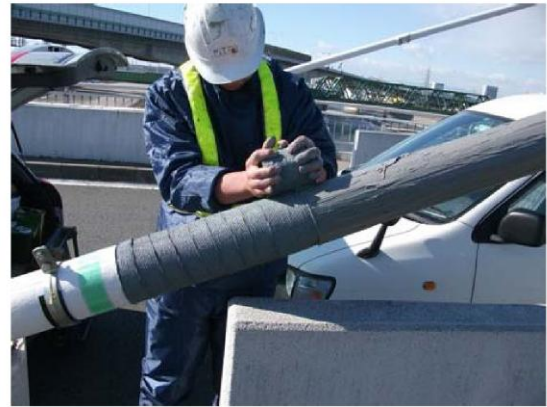
防食テープ巻き付け
