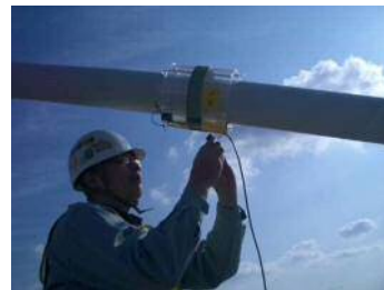
写真14.1 渦流探傷法測定状況
