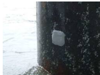
写真8 仮補修材
