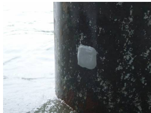
写真8 仮補修材
