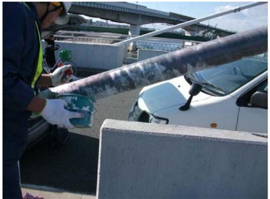
樹脂塗布含浸（FRP下塗り工程完了）
