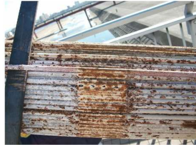
ポリエチレンシートを固定していた箇所
