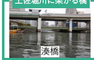
土佐堀川に架かる橋
