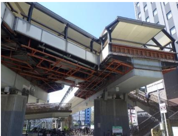
桁カバーの一時撤去箇所
