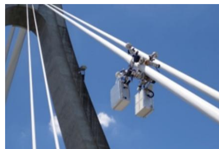
自走式点検ロボットによる 斜材表面の変状確認
