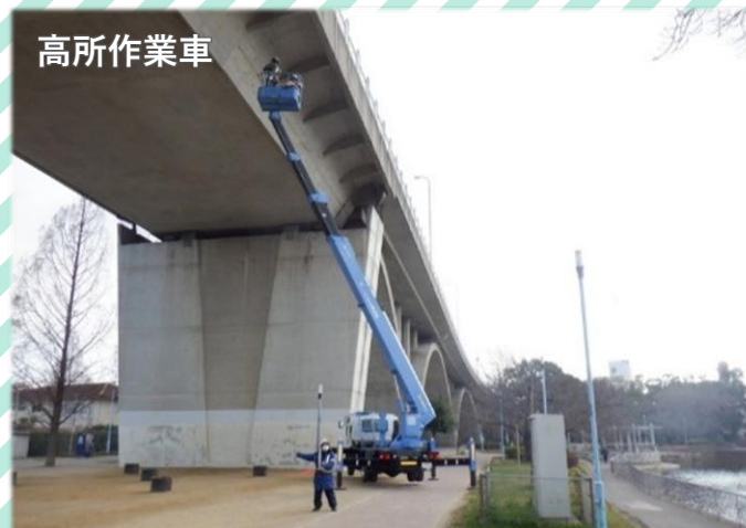
全磁束法による腐食調査
