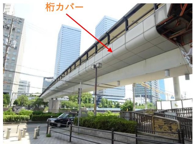
桁カバーの状況
