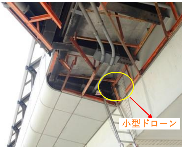
桁カバー内部の状況
