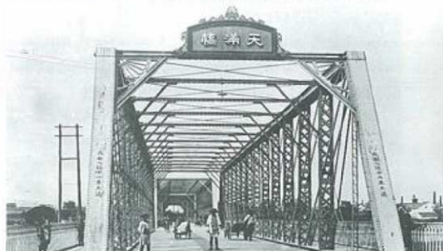
▼ 復旧後の天満橋 明治21年完成。 トラスの主橋間が車馬道で、外側が人道。
