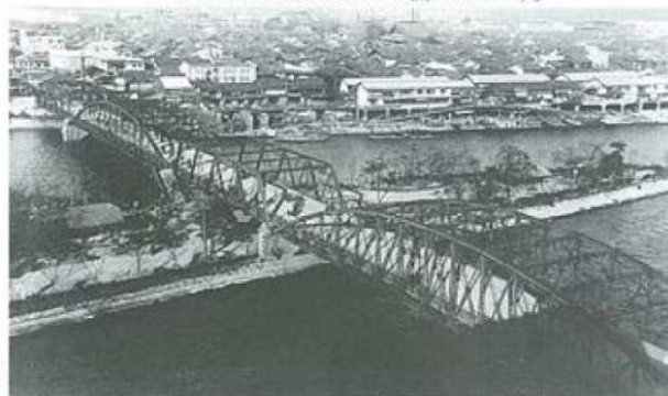
▼ 復旧後の天神橋 明治21年完成。 あまりの長径間に、人々は驚いたという。
