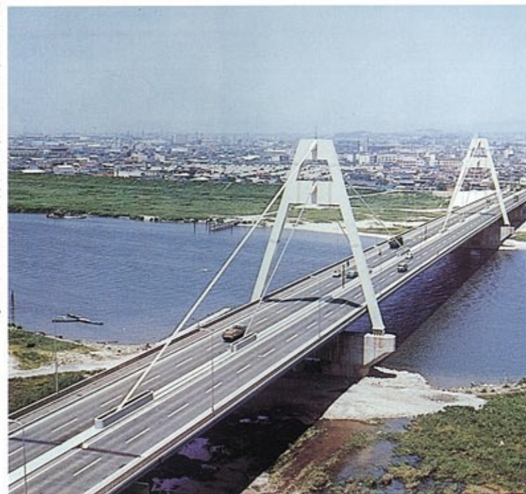
▲日本初の本格的な斜張橋——豊里大橋(昭和45年完成)
