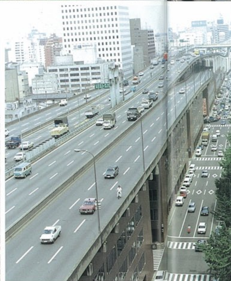
▲ビルの上を利用した——中央大通の高架橋(昭和45年完成)
