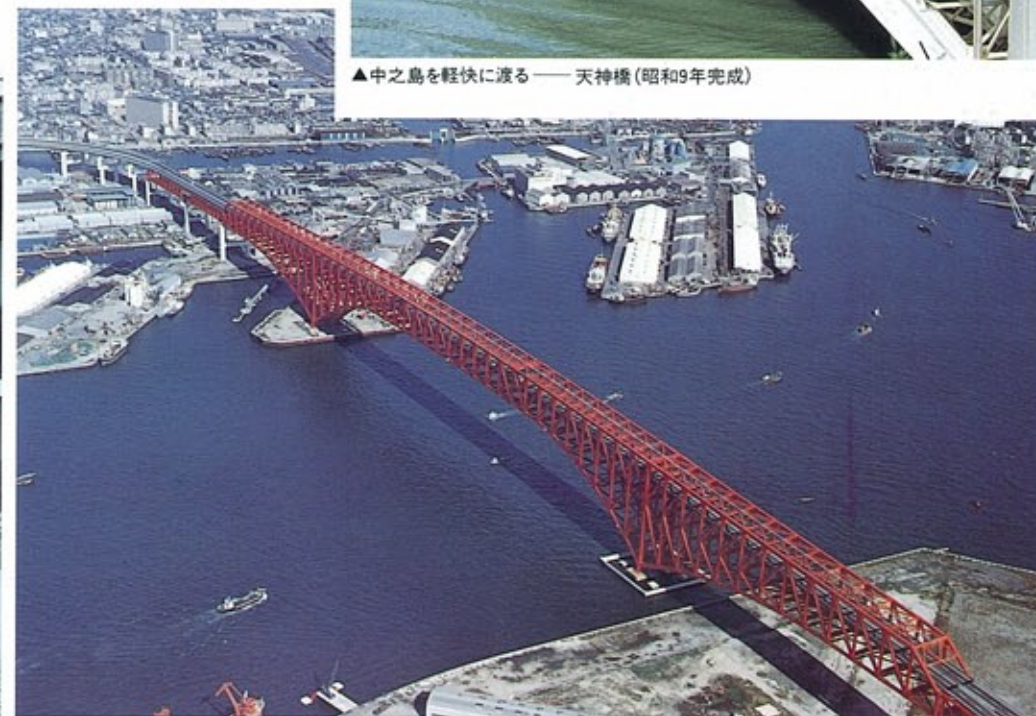
▲大阪港の主航路をひとまたぎする——港大橋(昭和49年完成)
