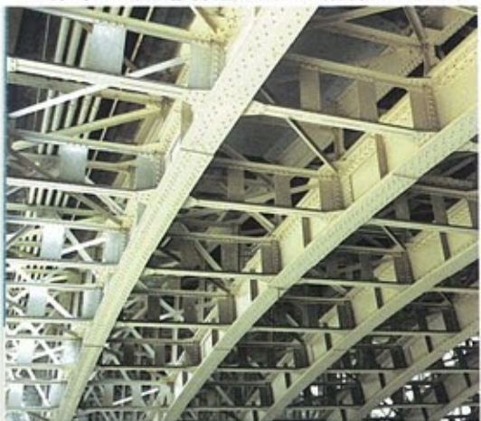
▼橋は多くの供給管を安全に渡す——天神橋(昭和9年完成)
