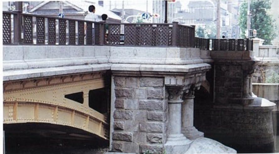
▲現役では、大阪で最も古い——本町橋(大正2年完成、昭和57年改修)
