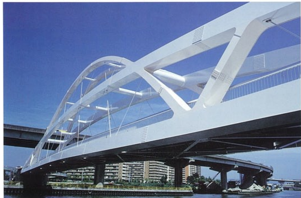
▼新しい住宅地・淀川リバーサイドタウンの利便をはかる——飛翔橋(昭和59年完成)
