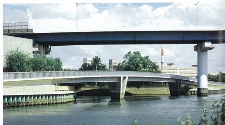
▲連続感が強調されたコンクリートの橋——春風橋(昭和56年完成)
