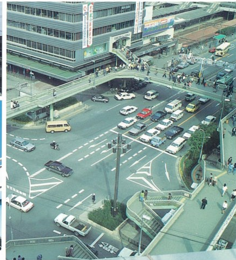
▼ターミナルを結ぶ——阿倍野歩道橋(昭和40年完成)
