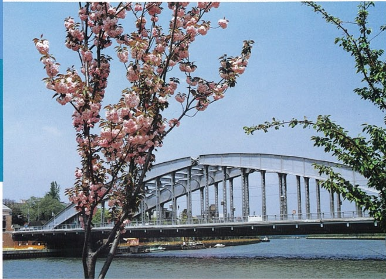
▼銀橋と愛称される重厚な3ヒンジアーチ——桜宮橋(昭和5年完成)
