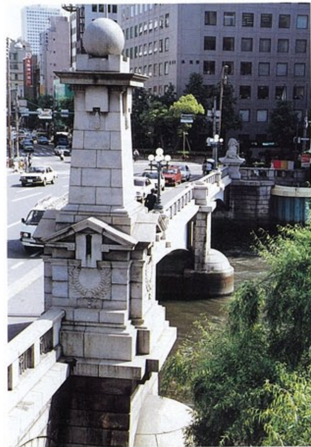
▲ライオン石像、華麗な飾塔などが中之島を彩る ——難波橋(大正4年完成、昭和50年改修)
