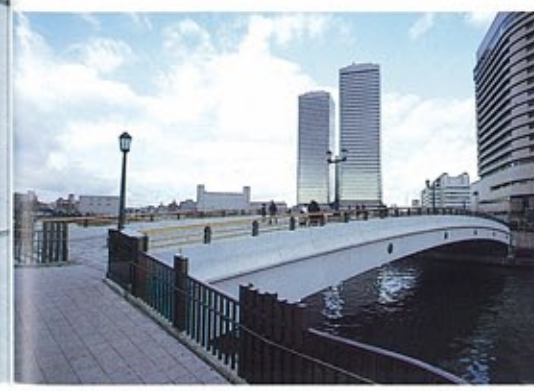
▲大阪ビジネスパークと大阪城公園を結ぶ——大阪城新橋(昭和58年完成)
