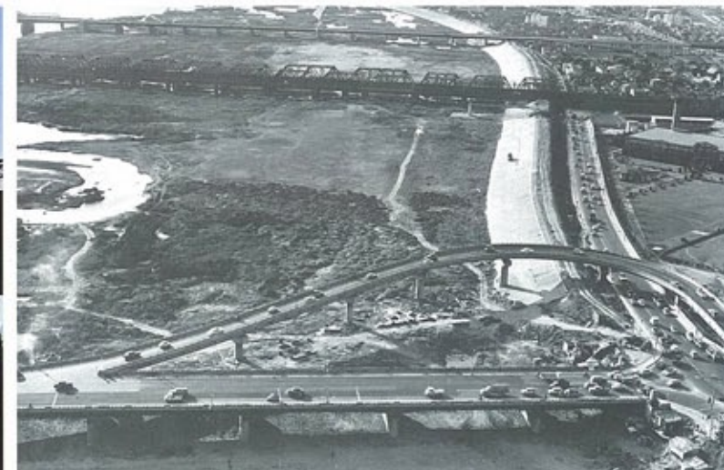
▲ 長柄バイパス (昭和39年完成) 本市における最初の曲線箱桁橋。
