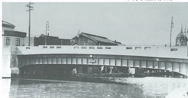
▼茂左衛門橋 昭和13年完成 橋台から突桁を出して桁を載せる構造から「突桁式鋼板桁」と呼ばれた。橋台後方の掘削を少なくできる利点があった。
