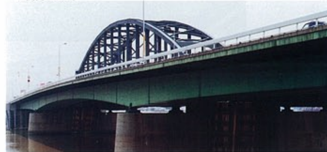
▼新淀川大橋 昭和39・44年完成。 第二次都市計画事業により淀川には道路と高速鉄道が併用される自碇式吊橋が計画された。昭和14年に橋台・橋脚を完成した時点で、戦争のため工事は中断した。現在の橋は、下部工は戦前のものを改修。上部工は鋼床版箱桁橋に変更された。
