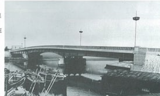
▶ 毛馬橋 (昭和35年完成) 我が国で最初の本格的な連続合成桁橋。 昭和54年に拡幅されて現在の姿となる。
