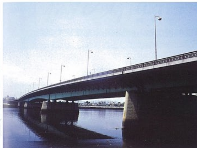
▲ 神崎橋 (昭和53年完成) 旧神崎橋に代わって、プレストレスしない連続合成桁橋として最大級の規模を誇る橋となった。
