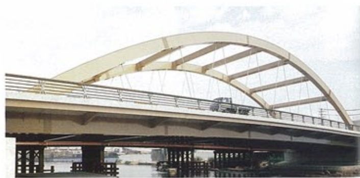
▲ 大和橋 (昭和49年完成) 豊里大橋につき、本市で2番目の斜張橋。 主桁が合成桁になっているのが特徴。
