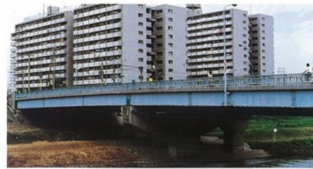
▶ 南港大橋 (東側昭和44年完成、西側昭和49年完成) 大阪湾岸線をはさんで、その両側で南港水路を渡るゲルバー式鋼床版箱桁橋。中央の大阪湾岸線南港水路橋は単弦ローゼで、上段の自動車専用道路と下段の新種交通「ニュートラム」とのダブルデッキ構造。
