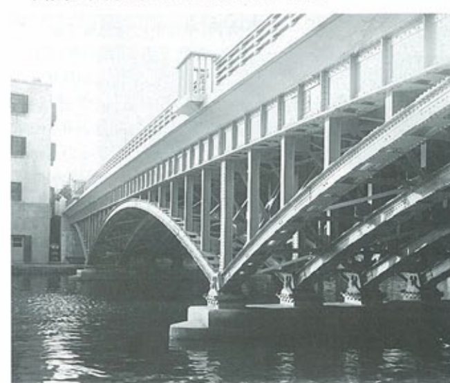
▼平野橋 昭和10年完成。 世界的にも例をみないといわれた逆ランガー形式。
