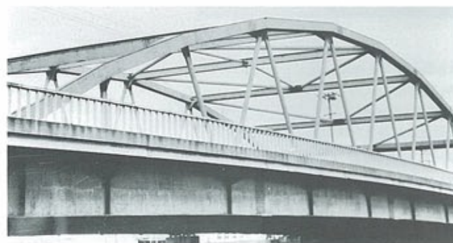
▲ 新福崎橋 (昭和41年完成) 本市における最初のトラスランガー橋。
