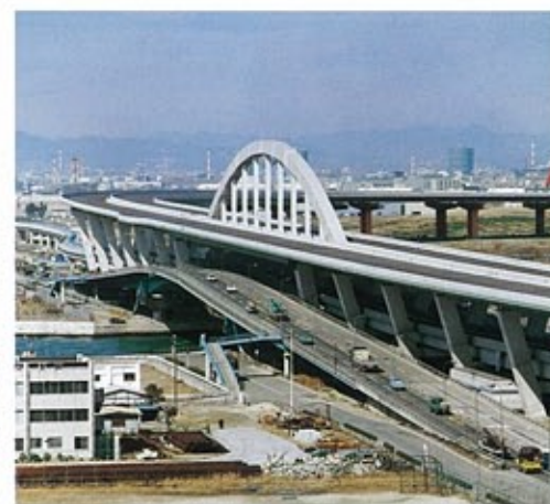
▶ 南港大橋 (東側昭和44年完成、西側昭和49年完成) 大阪湾岸線をはさんで、その両側で南港水路を渡るゲルバー式鋼床版箱桁橋。中央の大阪湾岸線南港水路橋は単弦ローゼで、上段の自動車専用道路と下段の新種交通「ニュートラム」とのダブルデッキ構造。
