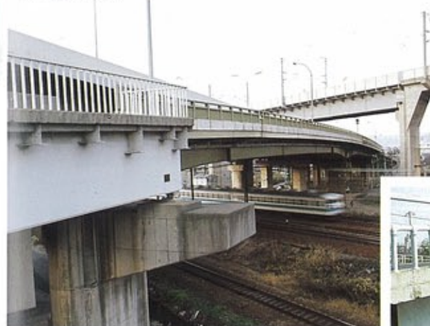
▲ 加島大島 (昭和38年完成) 森之宮における実験的な施工を活かして、鋼床版橋梁が長大化された。
