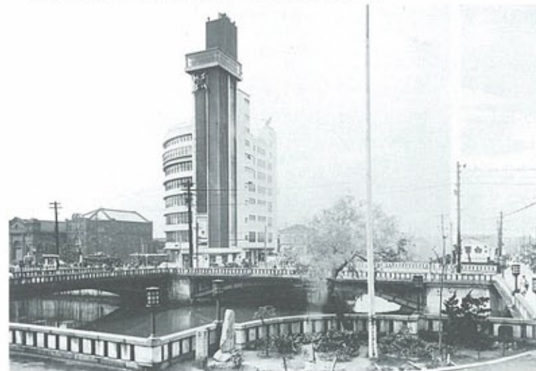
▼渡辺橋 昭和2年完成。 ルネサンス様式の意匠がほどこされた華麗なアーチ橋で、明治以降四代目にあたる。すなわち、明治初め頃の木橋、明治21年架設の鉄橋、明治41年の市電敷設にともなう架け換えを経て本橋となる。現在の橋は、昭和41年、高潮対策と地下鉄建設にともなう架け換えられた。
