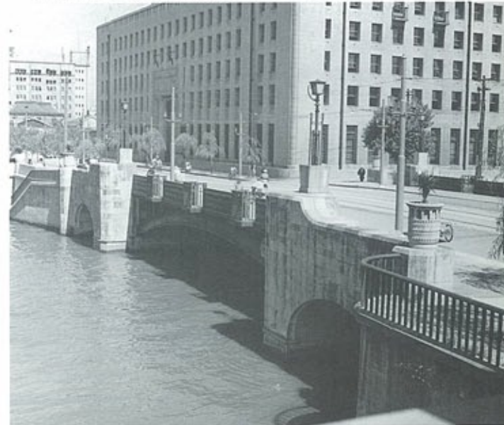
▼平野橋 昭和10年完成。 世界的にも例をみないといわれた逆ランガー形式。
