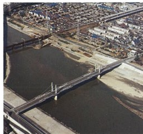
▲ 大和橋 (昭和49年完成) 豊里大橋につき、本市で2番目の斜張橋。 主桁が合成桁になっているのが特徴。
