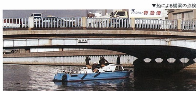
▼ 船による橋梁の点検
