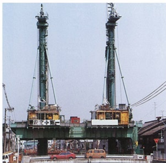
▲ 平野川水系の橋梁架換に使われたゴライアス(門型クレーンの一種)。
