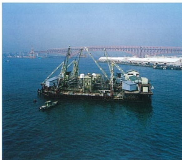
▲ なみはや大橋の大規模な築島とコンクリート打設。
