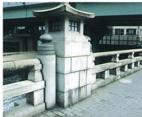
▲ 江戸時代橋詰にあった櫓屋敷を模した飾灯——高麗橋
