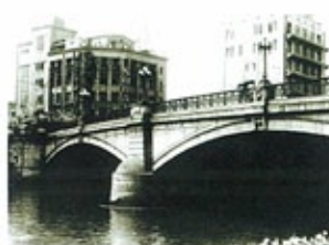
鉄橋になった難波橋
