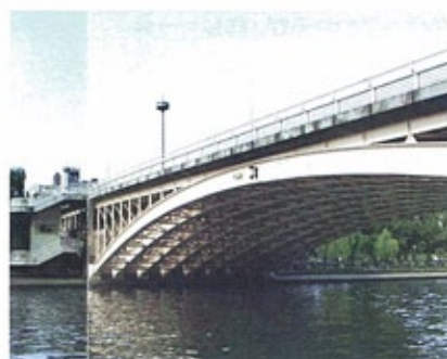
現在の天神橋
