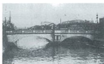
石造りアーチの心斎橋
