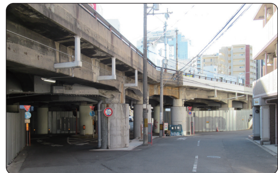
大規模長寿命化代表例：中津高架橋
